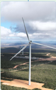
Parque Eólico Pedra Pintada
